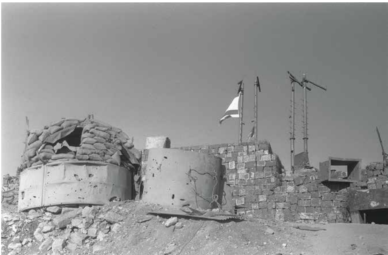
מוצב חרמון, 1973. מוצב ממוצע ברמת הגולן הוא מבנה שמבוסס על אבני בזלת ועל חציבה לקרקע בעומק של 2 קומות צילום: גד בינטר/לע"מ
